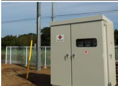
茨城県 高圧受電設備工事 基礎・設置
