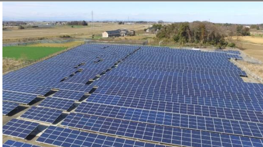
茨城県 太陽光発電設備工事 高圧受電
