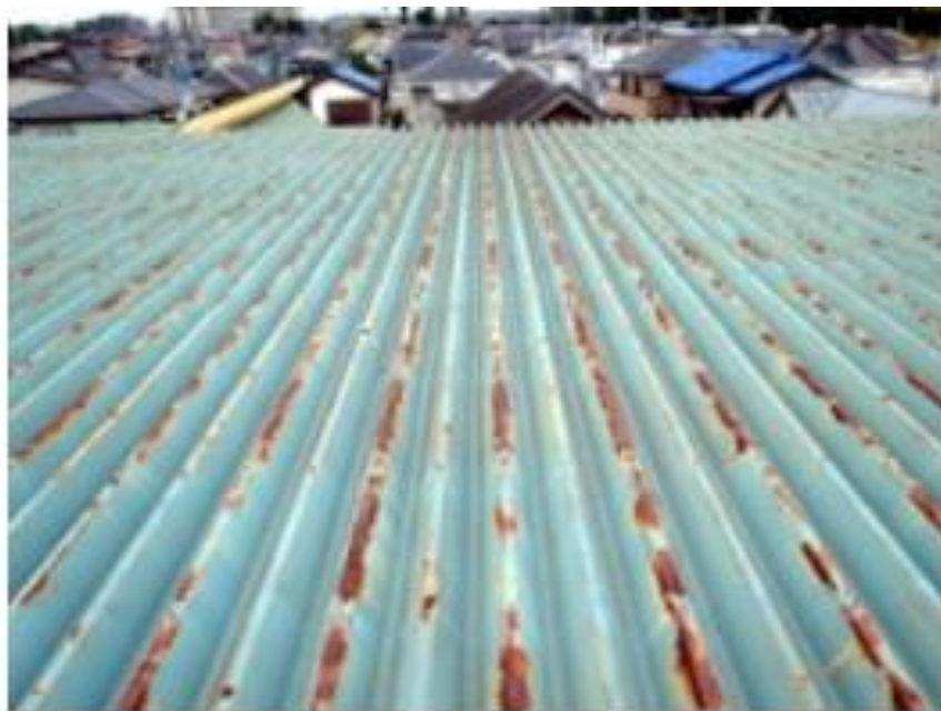
本社倉庫 施工前
