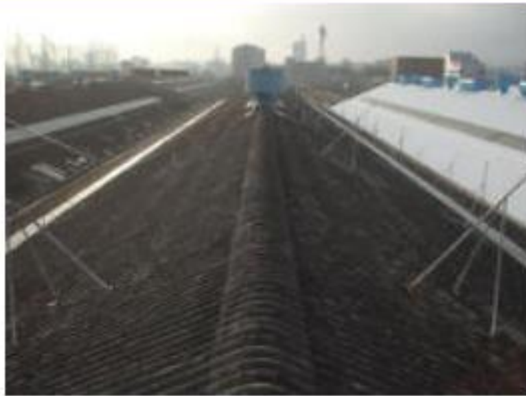
大分工場 施工前
