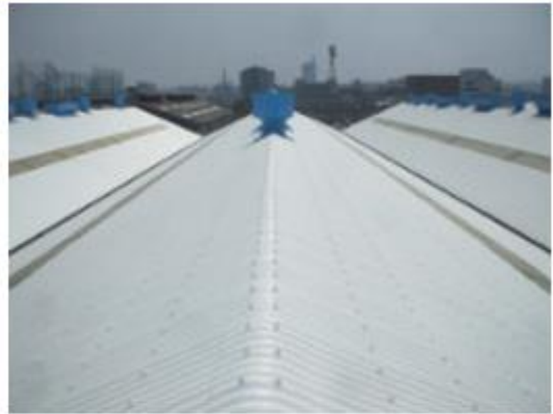
大分工場 施工後
